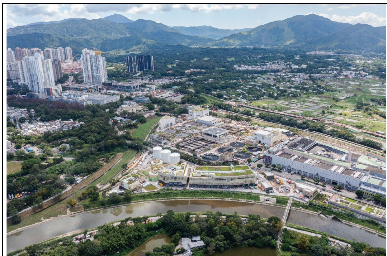
描述： 工地丙部分的航拍照片 (拍摄于2025年9月13日)
