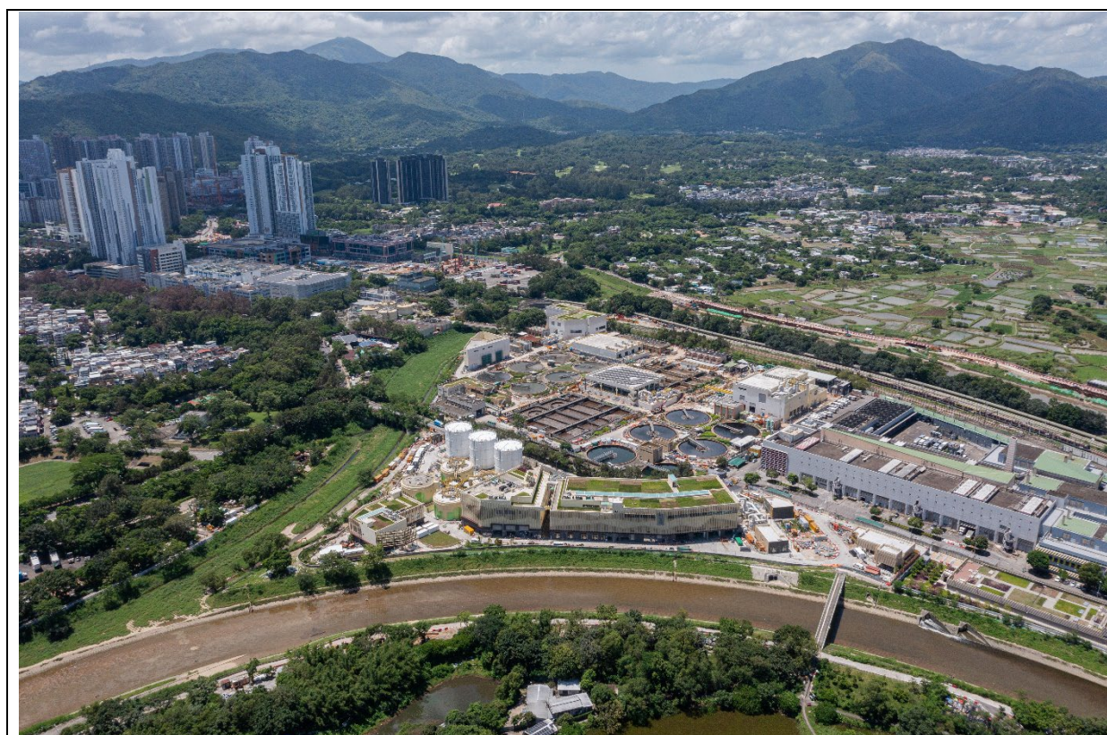
描述： 工地丙部分的航拍照片 (拍摄于2025年8月18日)
