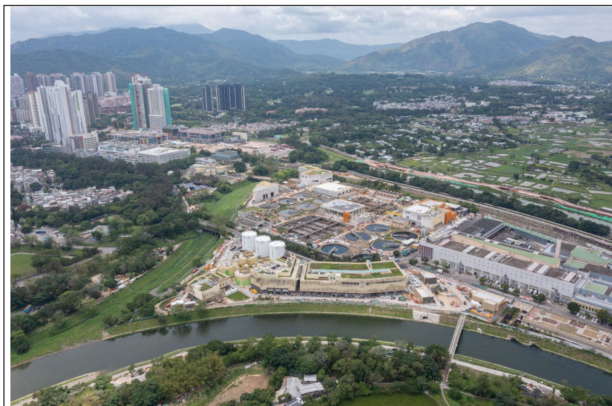
描述： 工地丙部分的航拍照片 (拍攝於2025年5月14日)
