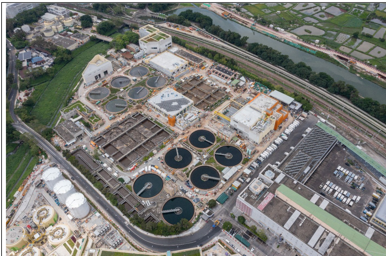
描述： 工地甲部分及乙部分的航拍照片 (拍摄于2025年5月14日)
