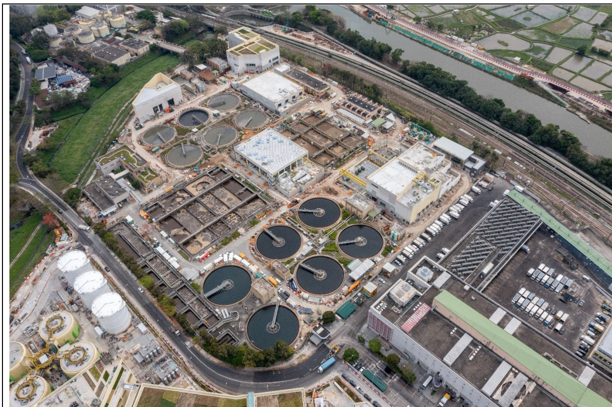
描述： 工地甲部分及乙部分的航拍照片 (拍摄于2025年3月18日)
