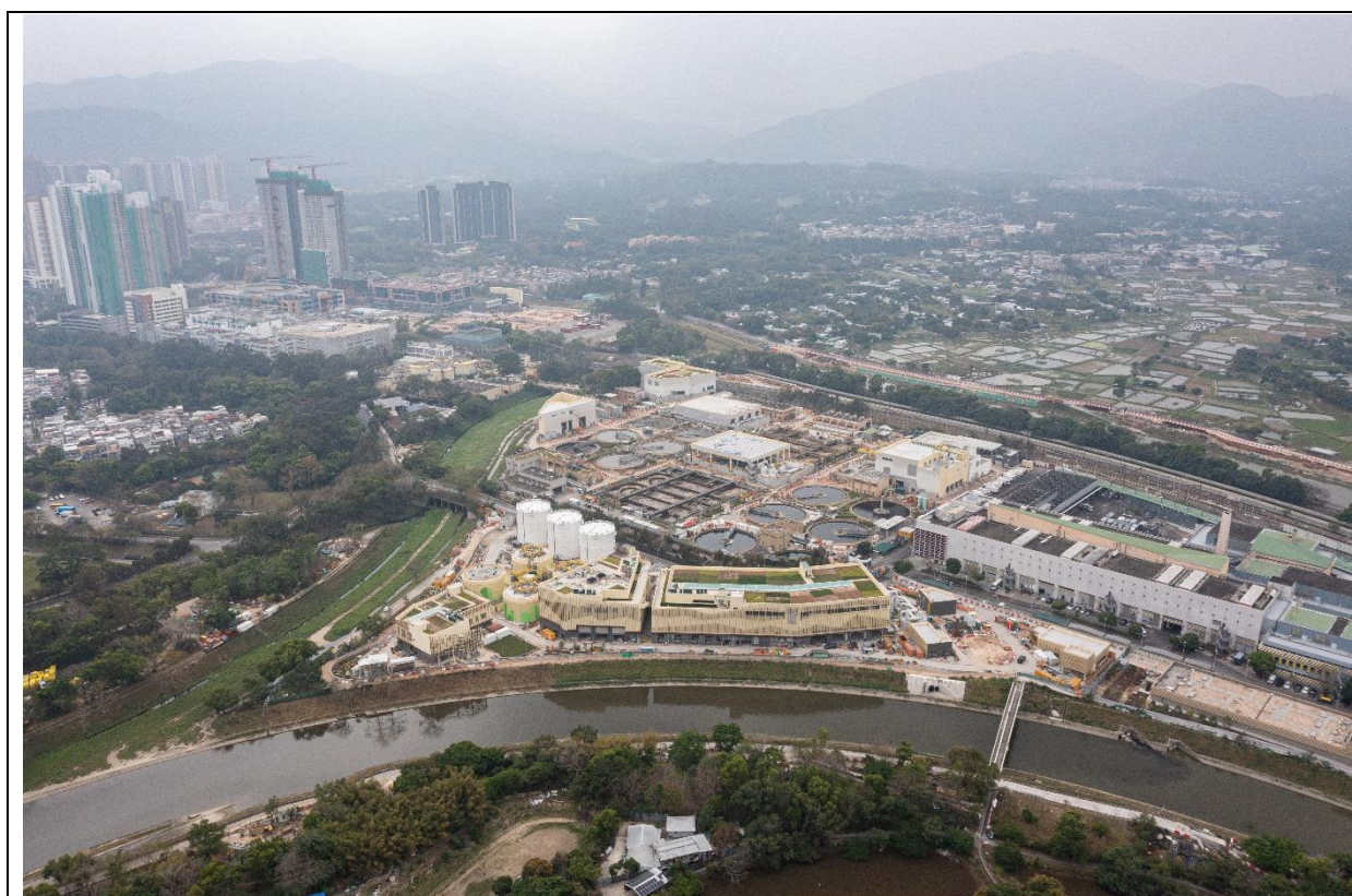
描述： 工地丙部分的航拍照片 (拍摄于2025年2月17日)
