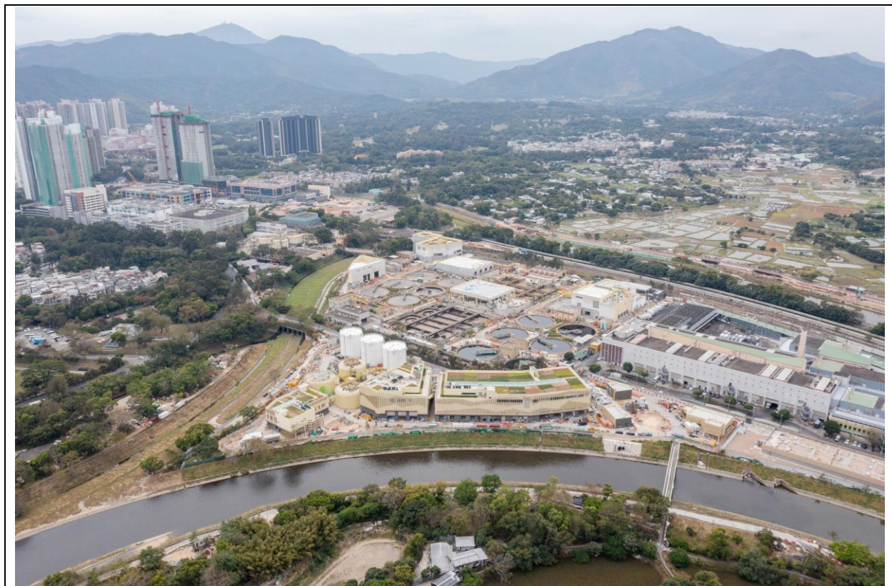
描述： 工地丙部分的航拍照片 (拍攝於2025年1月15日)
