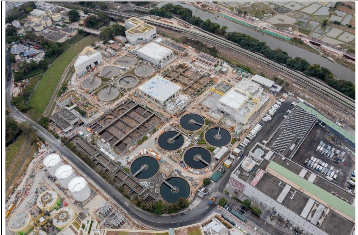
描述： 工地甲部分及乙部分的航拍照片 (拍攝於2025年1月15日)
