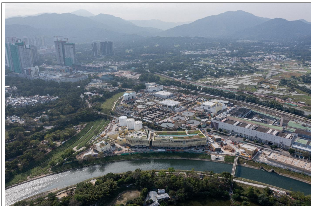
描述： 工地丙部分的航拍照片 (拍攝於2024年12月13日)
