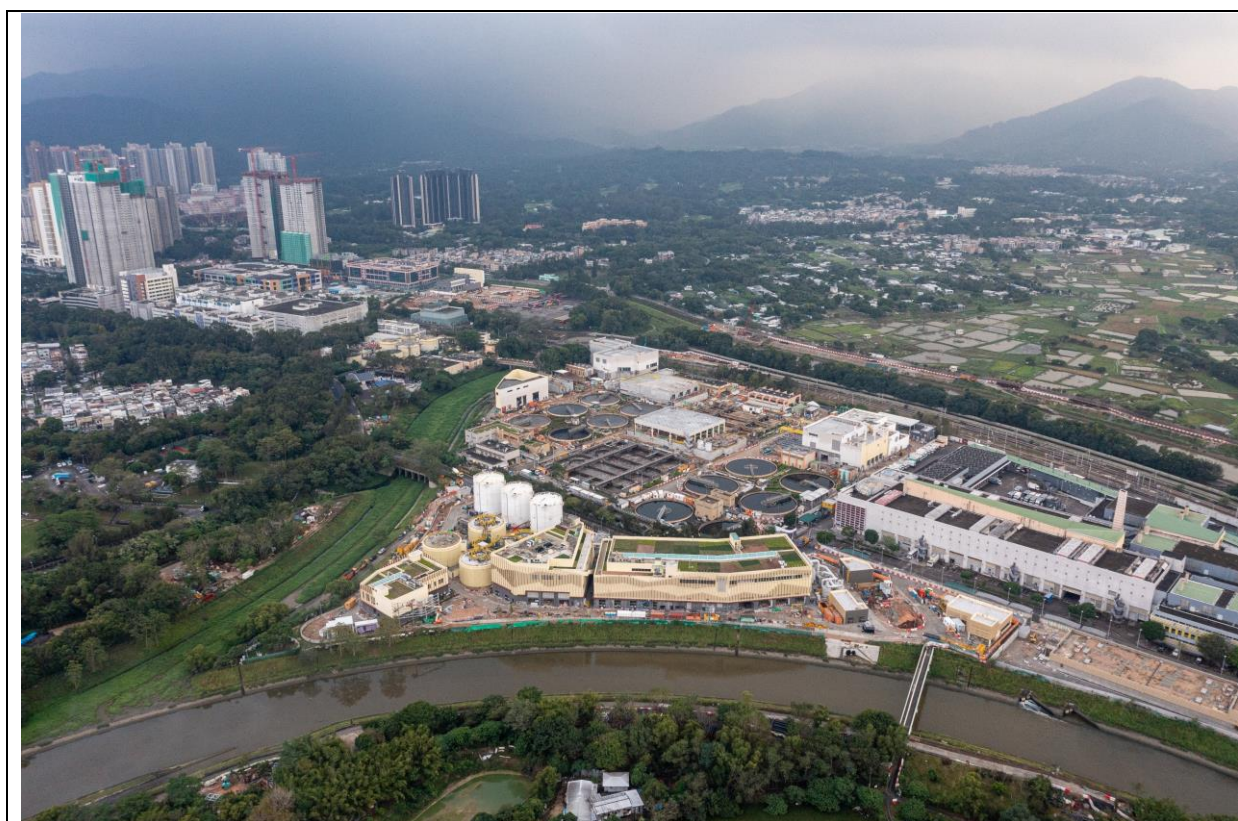
描述： 工地丙部分的航拍照片 (拍攝於2024年11月17日)
