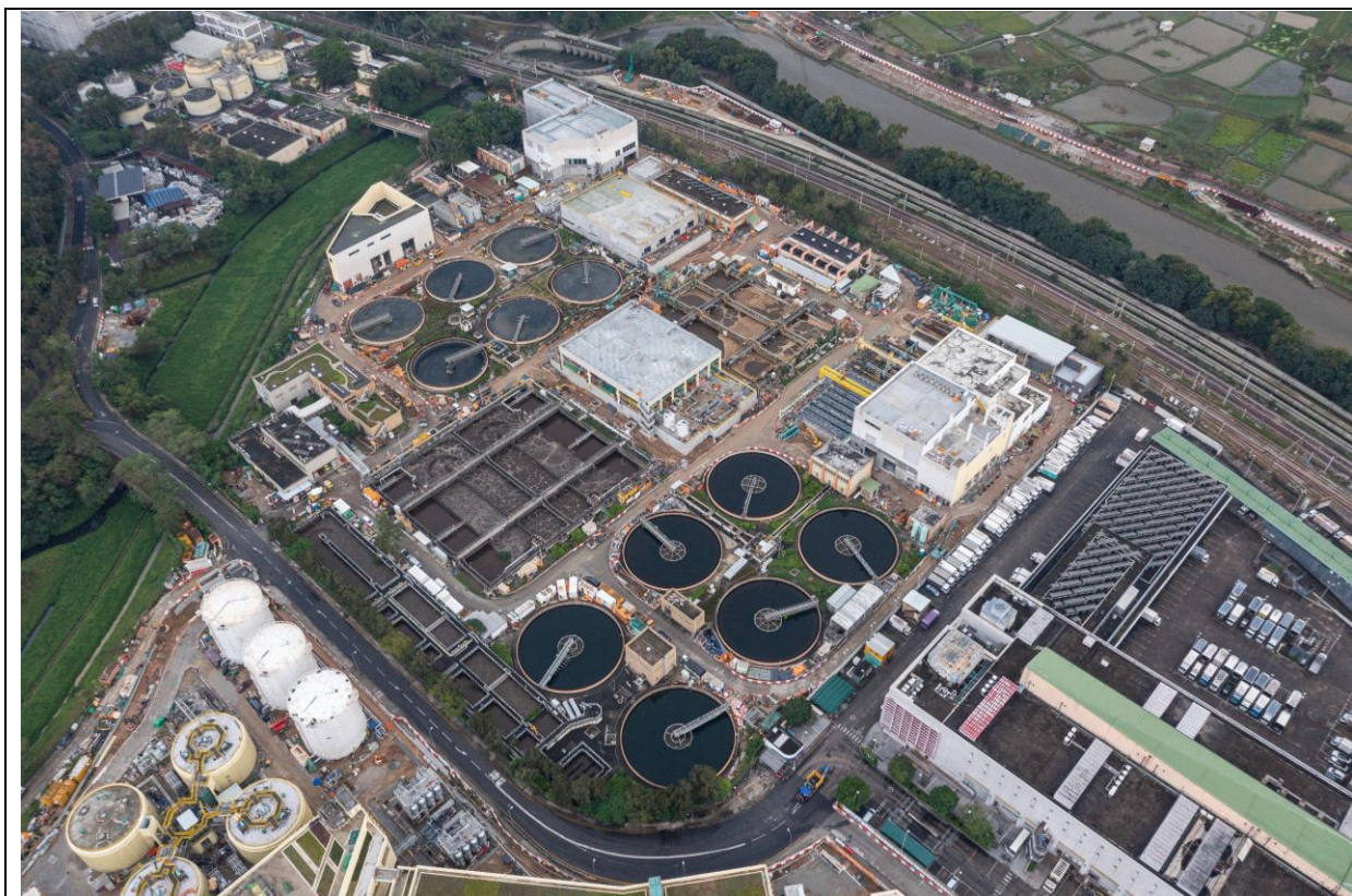
描述： 工地甲部分及乙部分的航拍照片 (拍攝於2024年11月17日)
