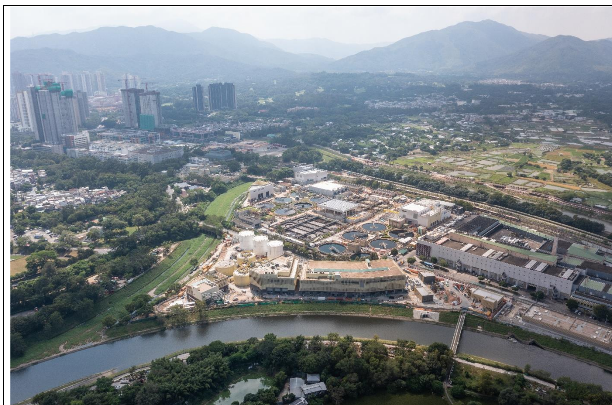
描述： 工地丙部分的航拍照片 (拍攝於2024年10月16日)
