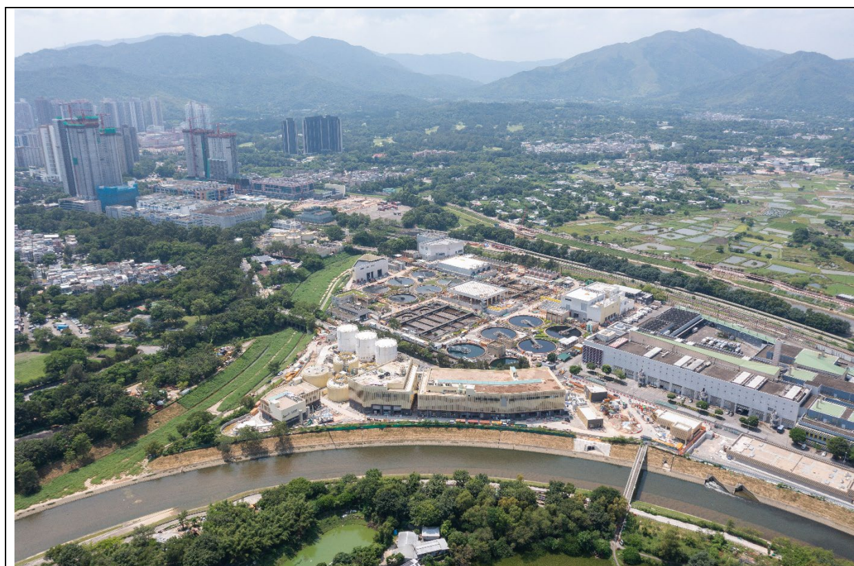
描述： 工地丙部分的航拍照片 (拍攝於2024年9月13日)
