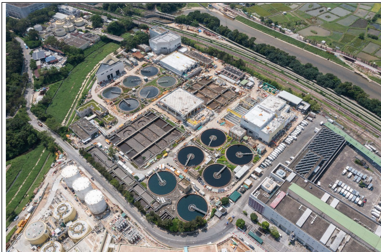
描述： 工地甲部分及乙部分的航拍照片 (拍摄于2024年9月13日)
