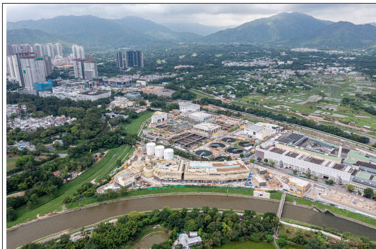
描述： 工地丙部分的航拍照片 (拍攝於2024年8月15日)
