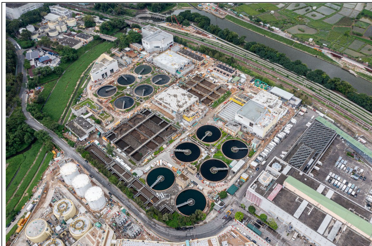
描述： 工地甲部分及乙部分的航拍照片 (拍攝於2024年8月15日)
