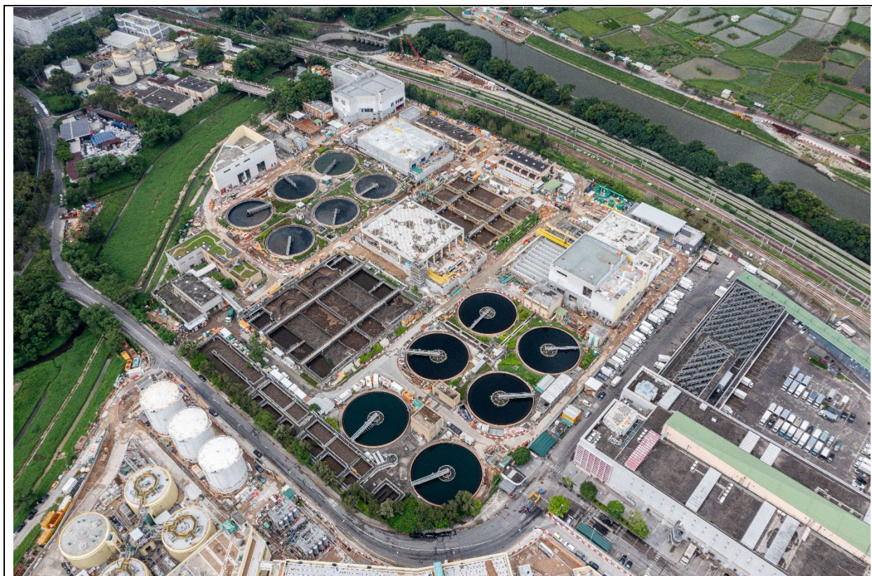
描述： 工地甲部分及乙部分的航拍照片 (拍摄于2024年8月15日)
