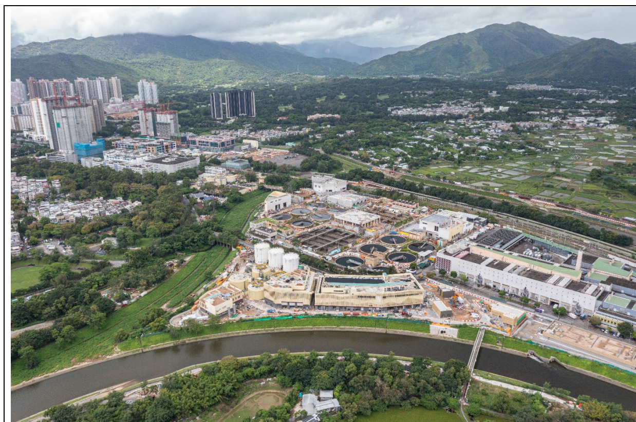
描述： 工地丙部分的航拍照片 (拍攝於2024年7月16日)
