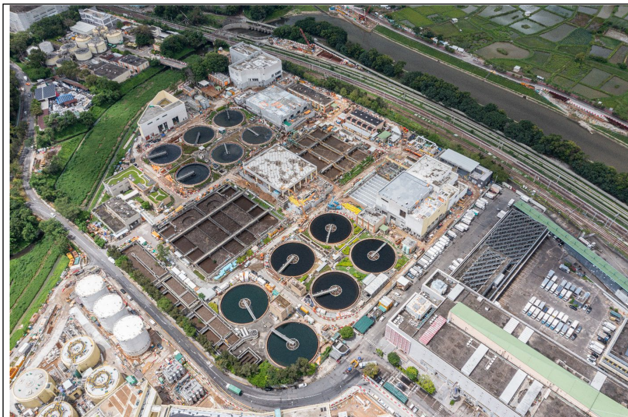
描述： 工地甲部分及乙部分的航拍照片 (拍攝於2024年7月16日)
