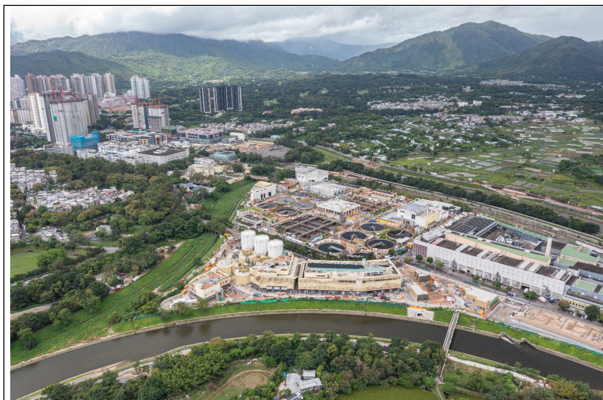
描述： 工地丙部分的航拍照片 (拍摄于2024年7月16日)
