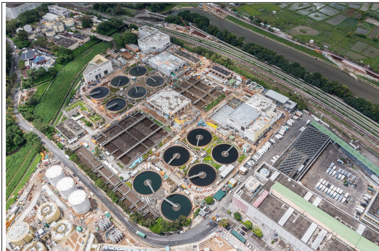
描述： 工地甲部分及乙部分的航拍照片 (拍摄于2024年7月16日)
