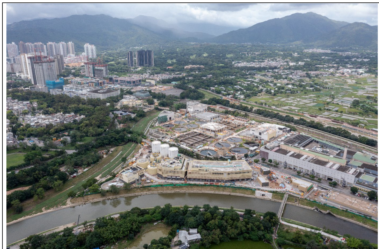
描述： 工地丙部分的航拍照片 (拍攝於2024年6月19日)
