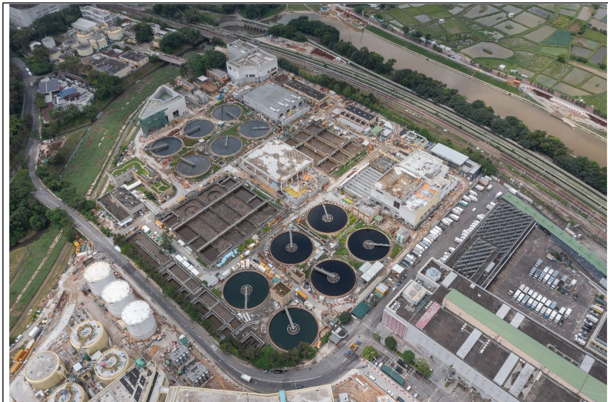
描述： 工地甲部分及乙部分的航拍照片 (拍摄于2024年6月19日)
