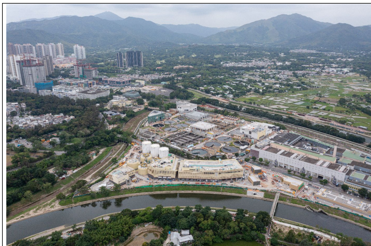
描述： 工地丙部分的航拍照片 (拍攝於2024年5月17日)
