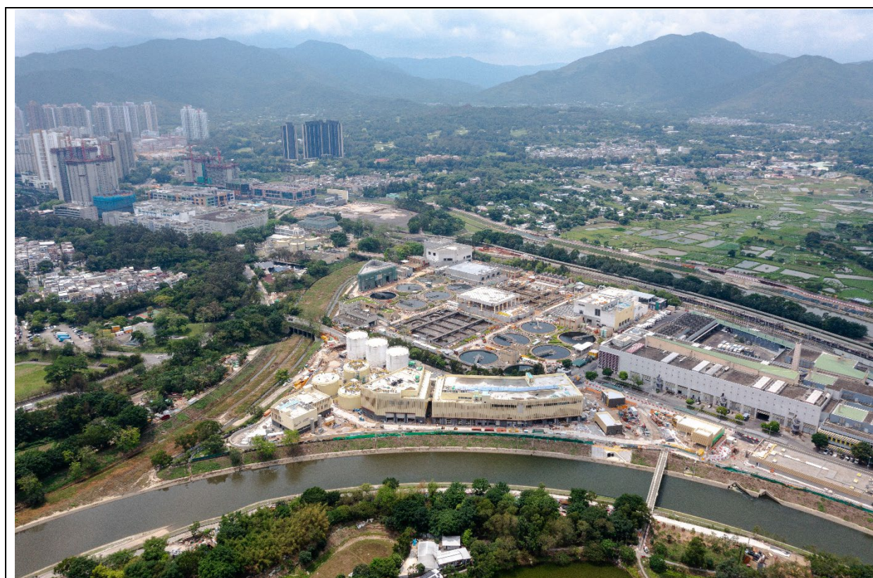
描述： 工地丙部分的航拍照片 (拍攝於2024年4月19日)
