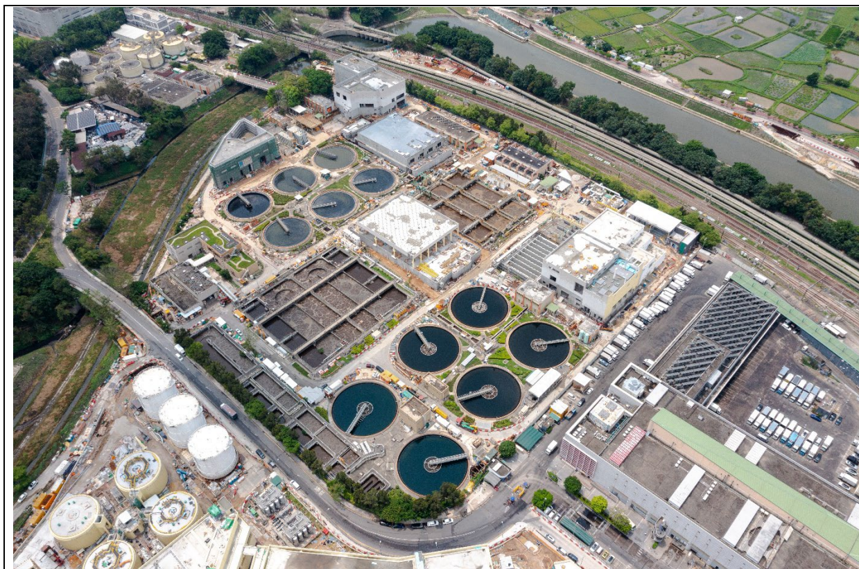
描述： 工地甲部分及乙部分的航拍照片 (拍攝於2024年4月19日)
