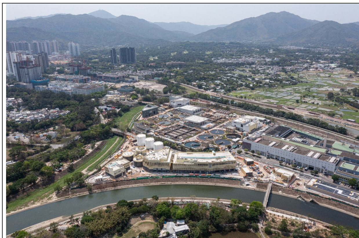
描述： 工地丙部分的航拍照片 (拍攝於2024年3月20日)
