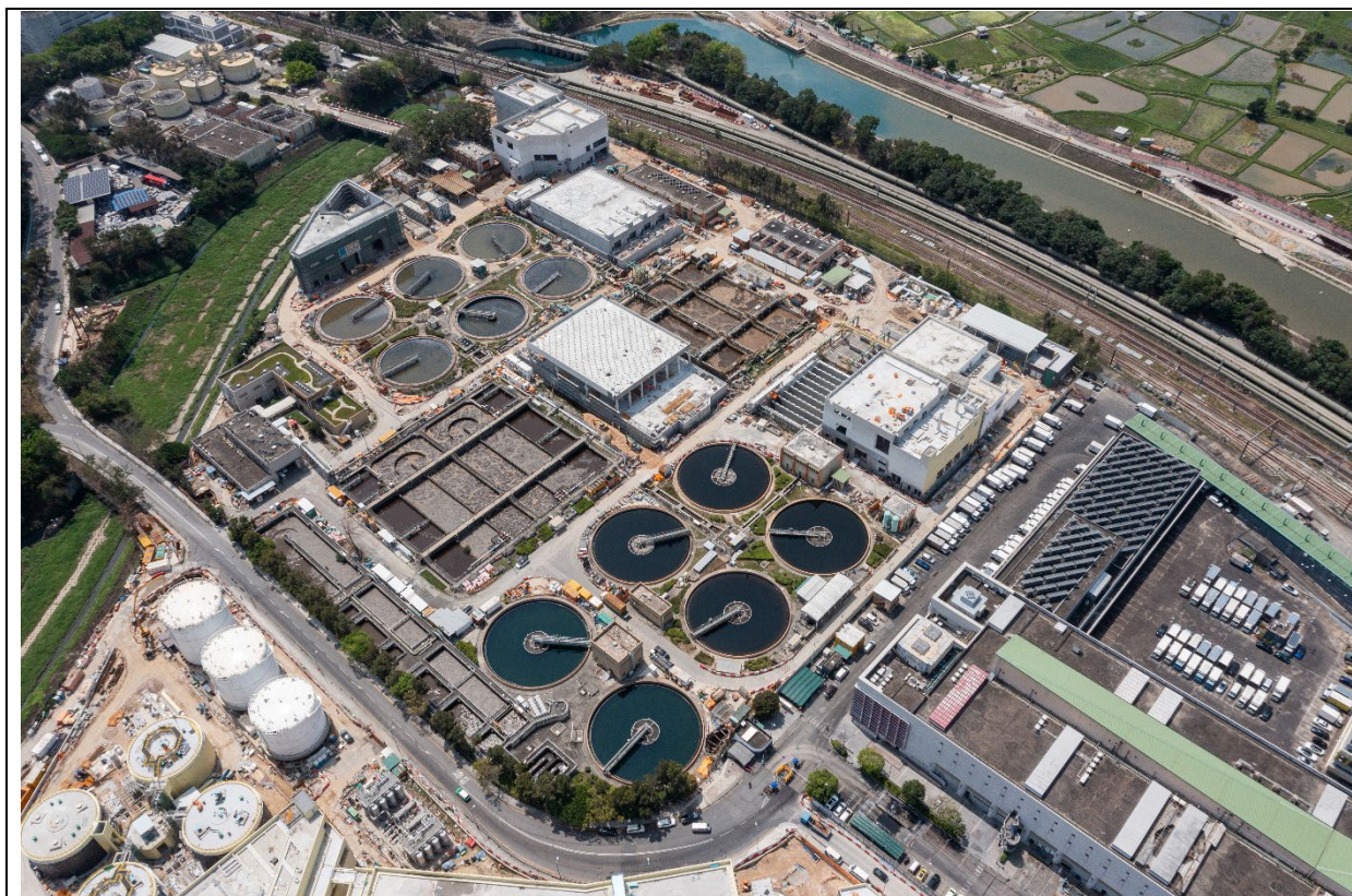
描述： 工地甲部分及乙部分的航拍照片 (拍攝於2024年3月20日)
