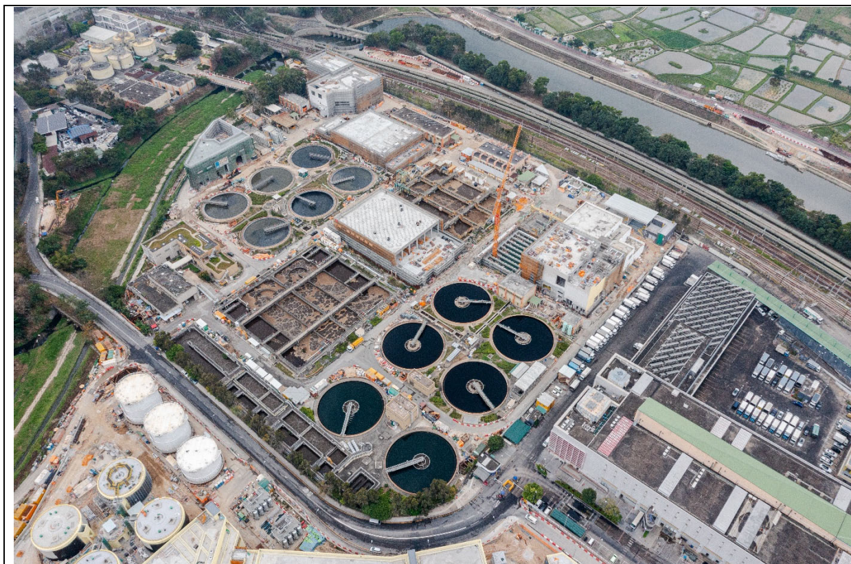
描述： 工地甲部分及乙部分的航拍照片 (拍攝於2024年2月19日)
