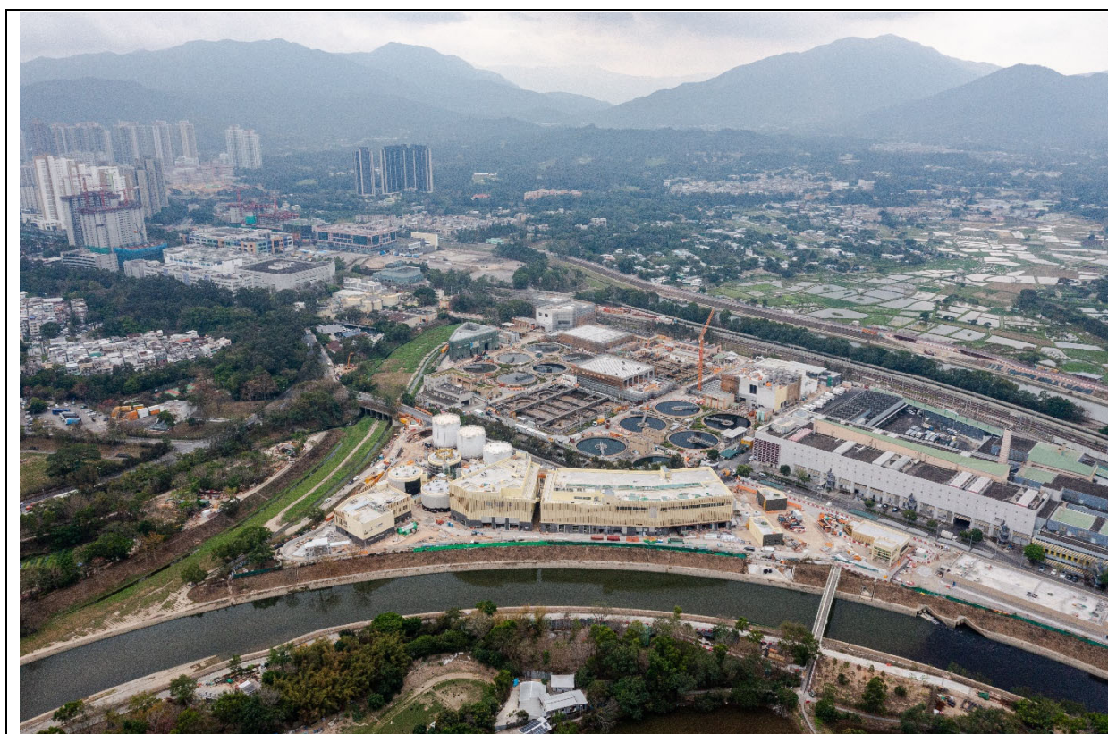
描述： 工地丙部分的航拍照片 (拍摄于2024年2月19日)
