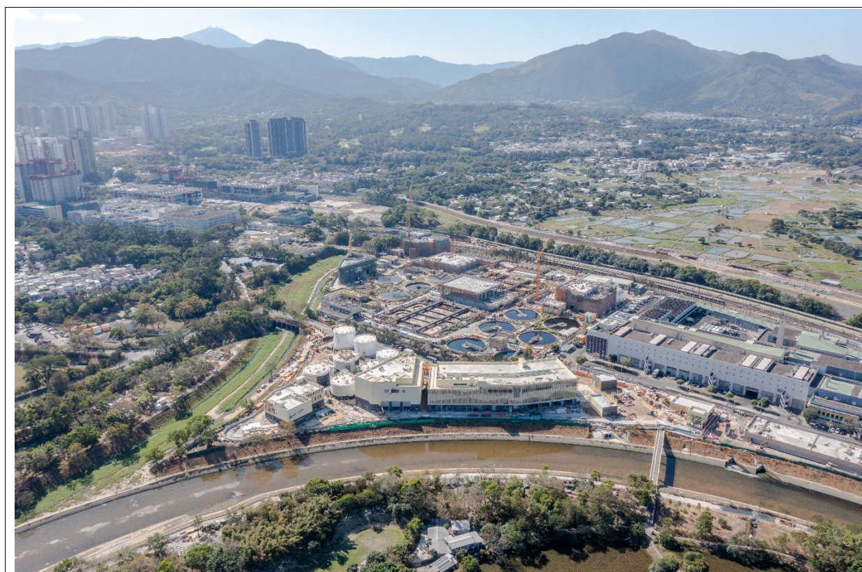
描述： 工地丙部分的航拍照片 (拍攝於2024年1月22日)
