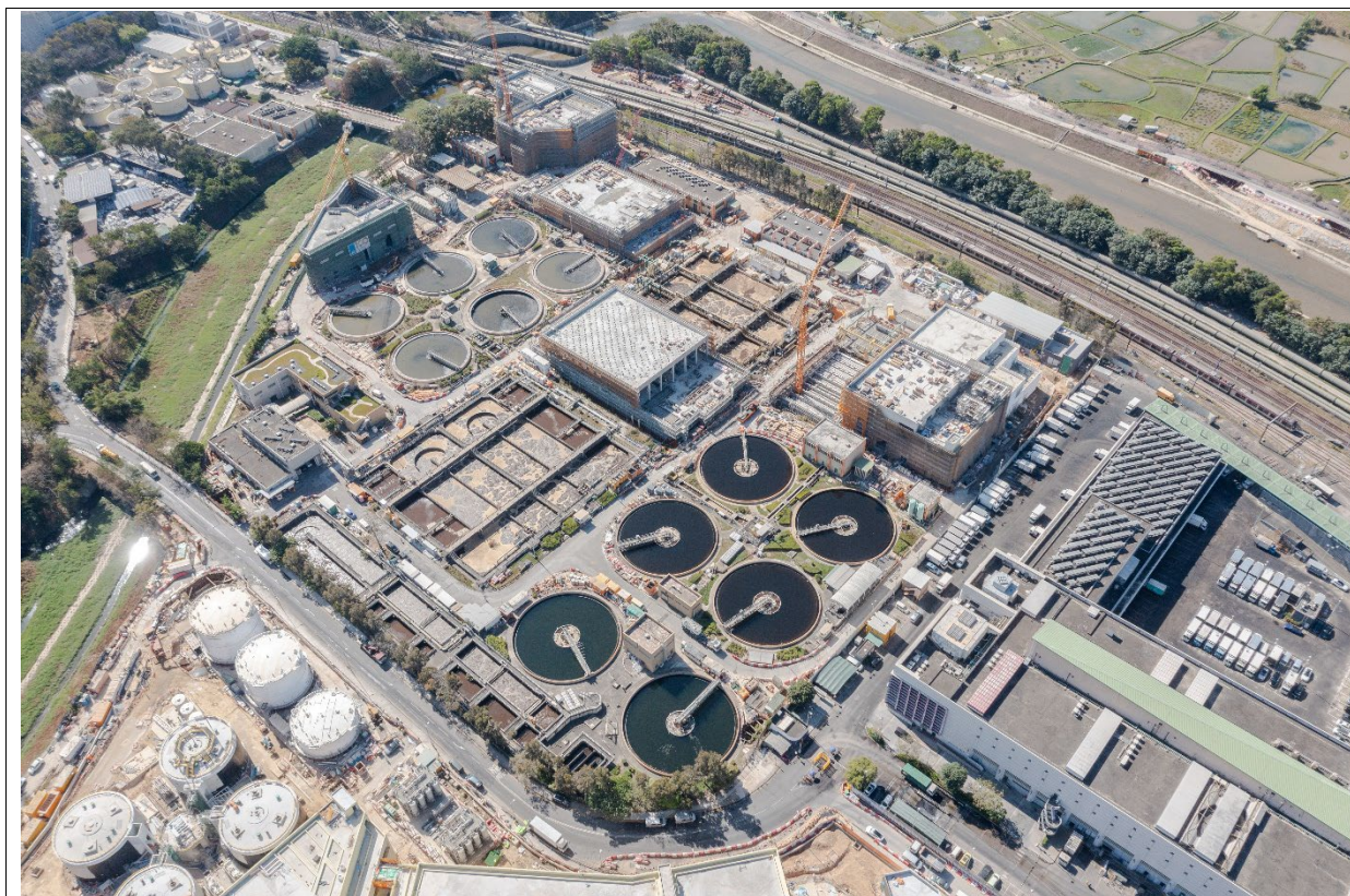
描述： 工地甲部分及乙部分的航拍照片 (拍摄于2024年1月22日)
