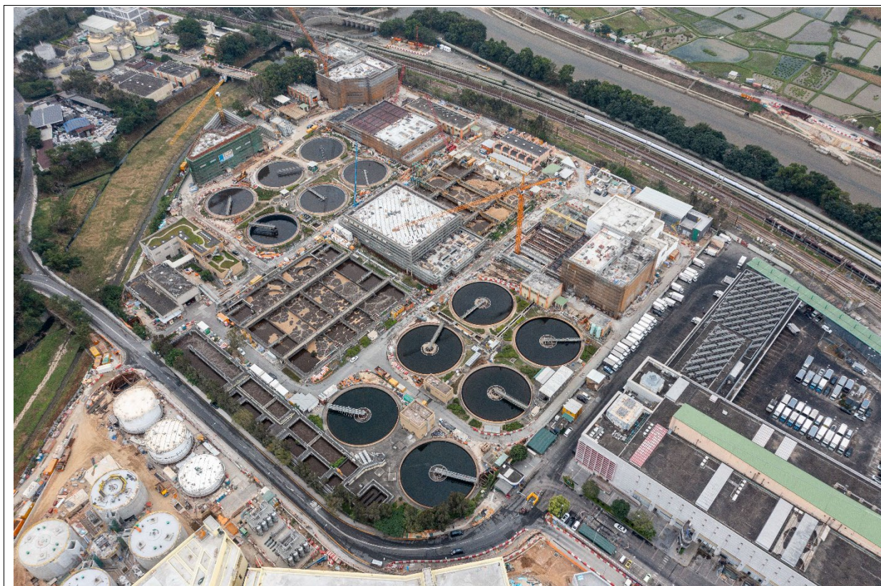
描述： 工地甲部分及乙部分的航拍照片 (拍攝於2023年12月19日)
