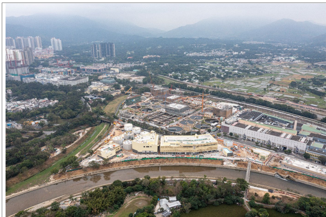
描述： 工地丙部分的航拍照片 (拍攝於2023年12月19日)
