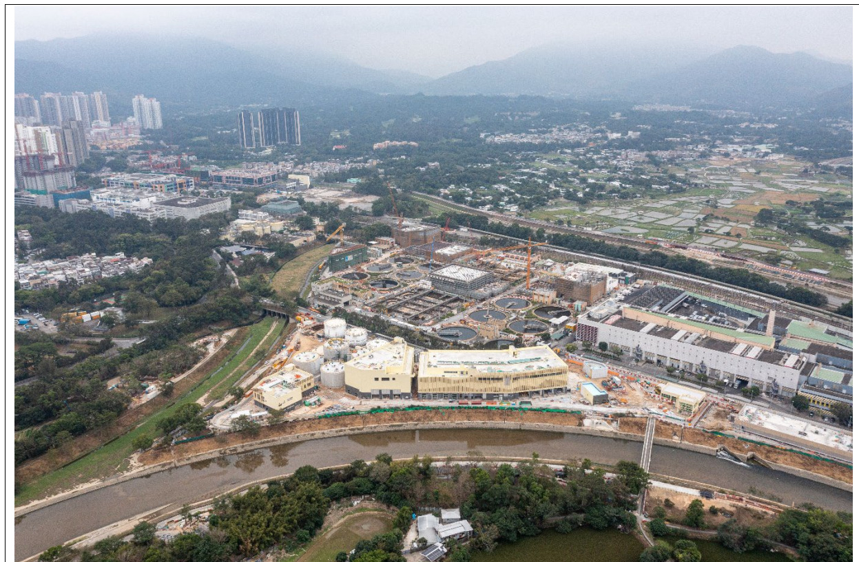
描述： 工地丙部分的航拍照片 (拍摄于2023年12月19日)
