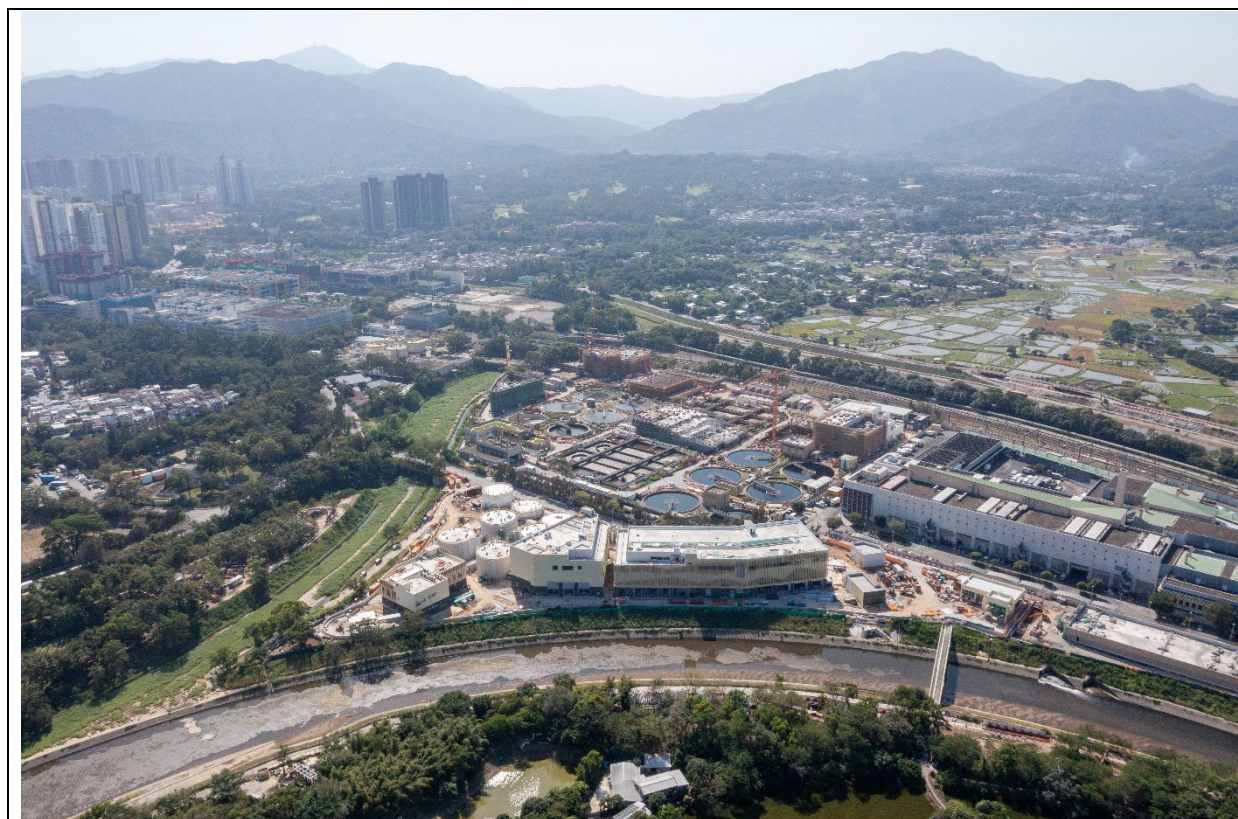
描述： 工地丙部分的航拍照片 (拍摄于2023年11月20日)
