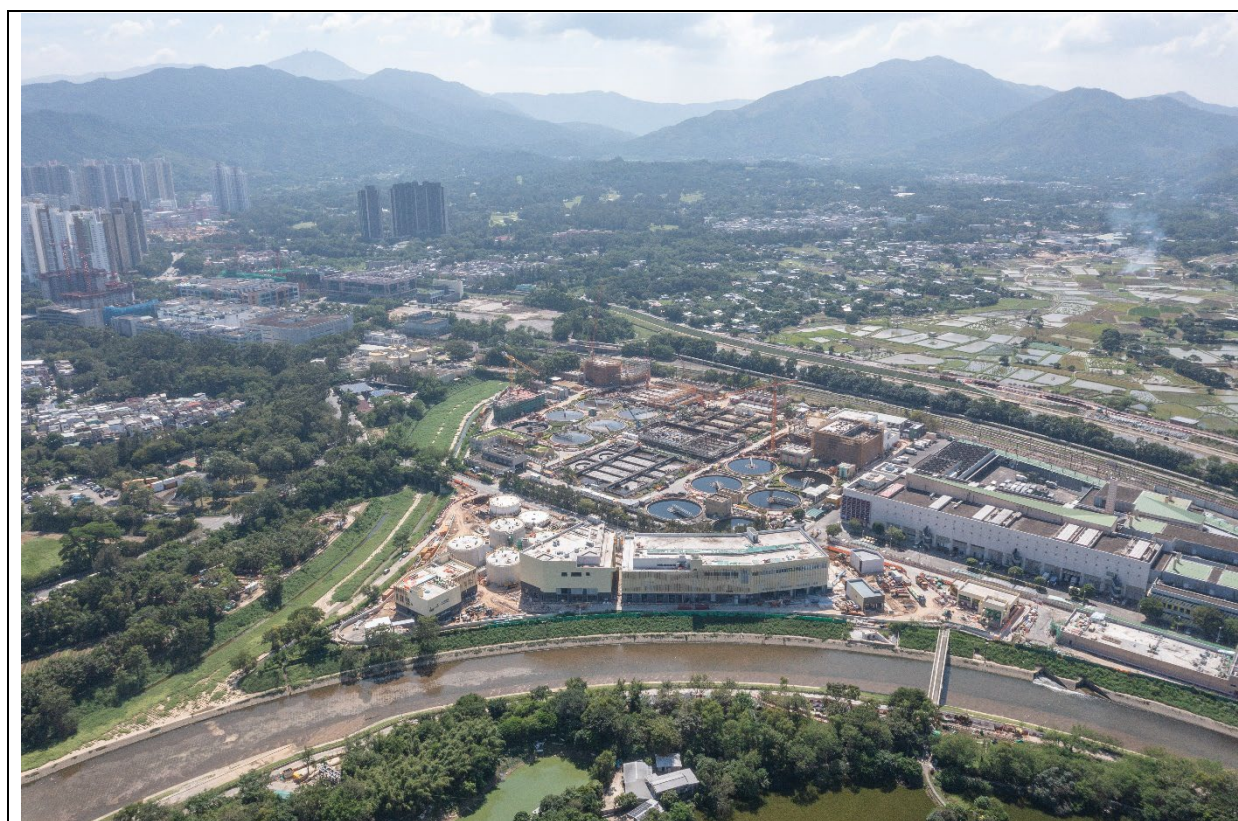
描述： 工地丙部分的航拍照片 (拍摄于2023年10月24日)
