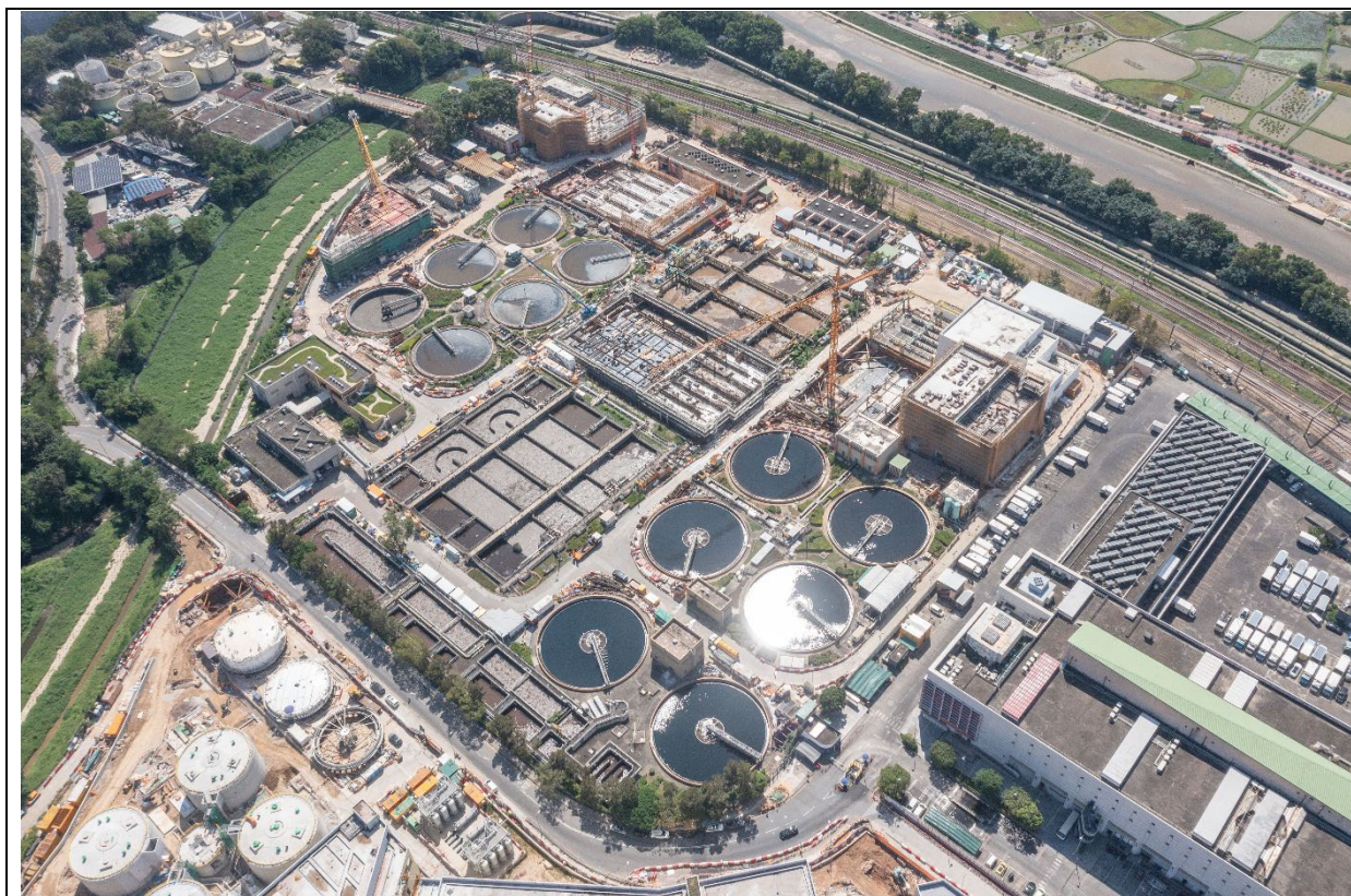
描述： 工地甲部分及乙部分的航拍照片 (拍摄于2023年10月28日)
