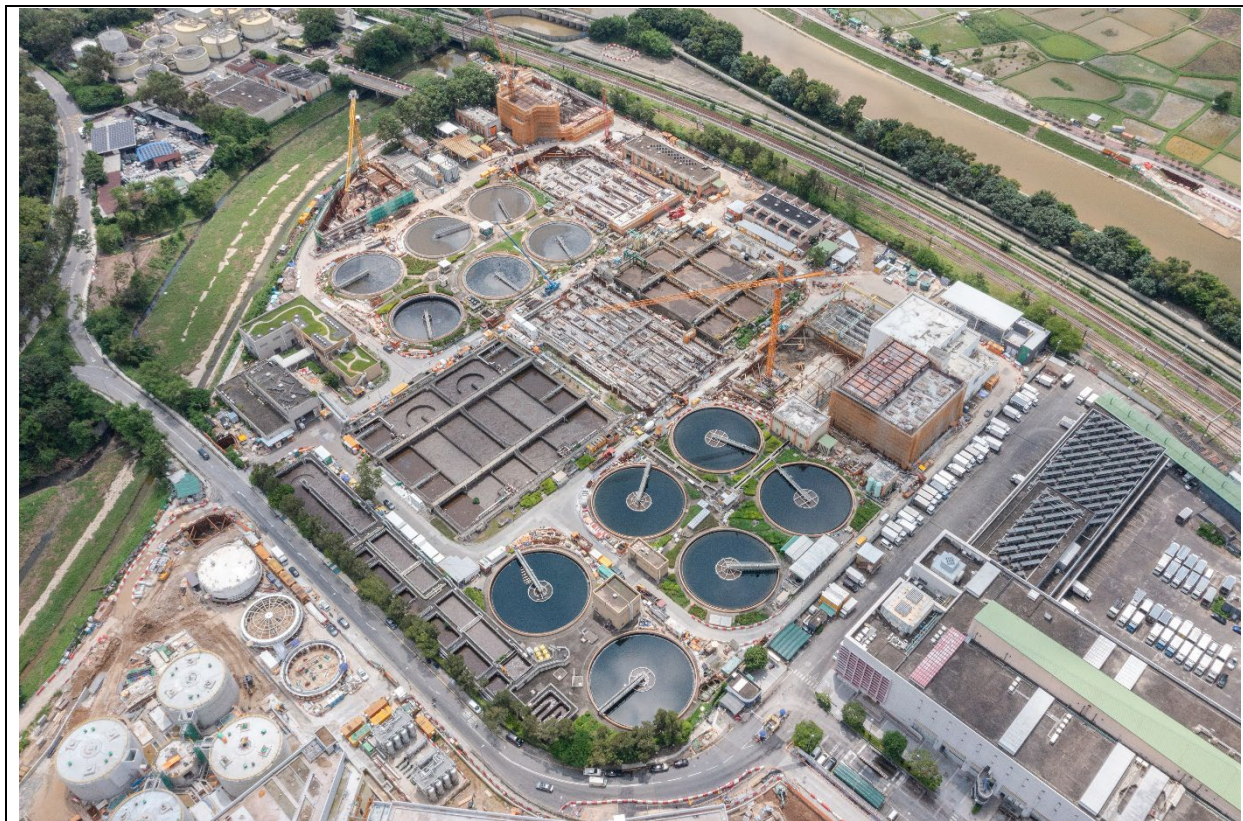
描述： 工地甲部分及乙部分的1號航拍照片 (拍攝於2023年9月23日)
