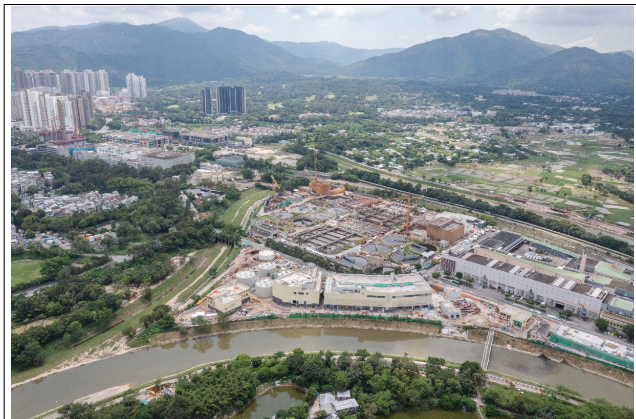
描述： 工地丙部分的1號航拍照片 (拍攝於2023年9月23日)
