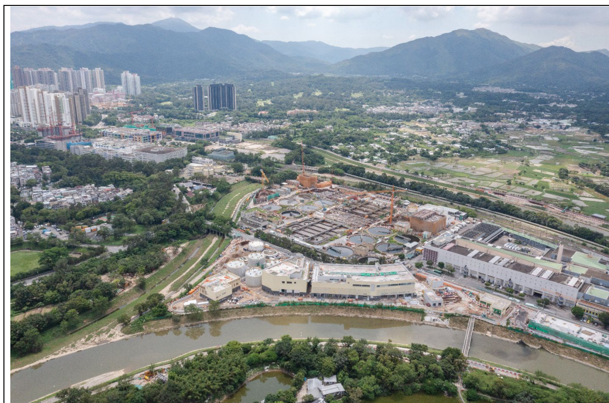
描述： 工地丙部分的1号航拍照片 (拍摄于2023年9月23日)
