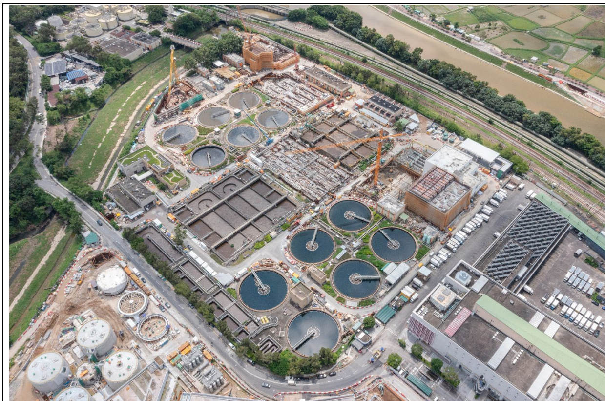
描述： 工地甲部分及乙部分的1号航拍照片 (拍摄于2023年9月23日)
