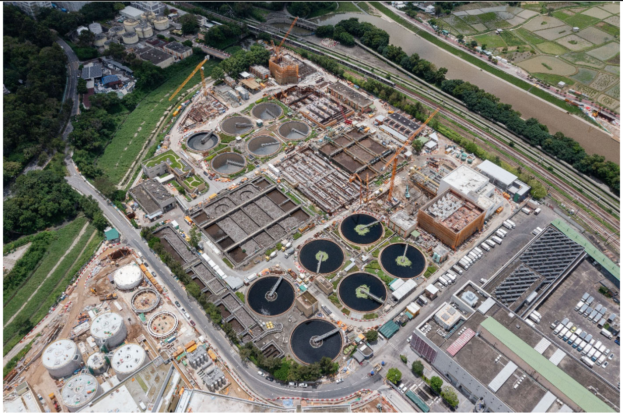
描述： 工地甲部分及乙部分的1號航拍照片 (拍攝於2023年8月21日)
