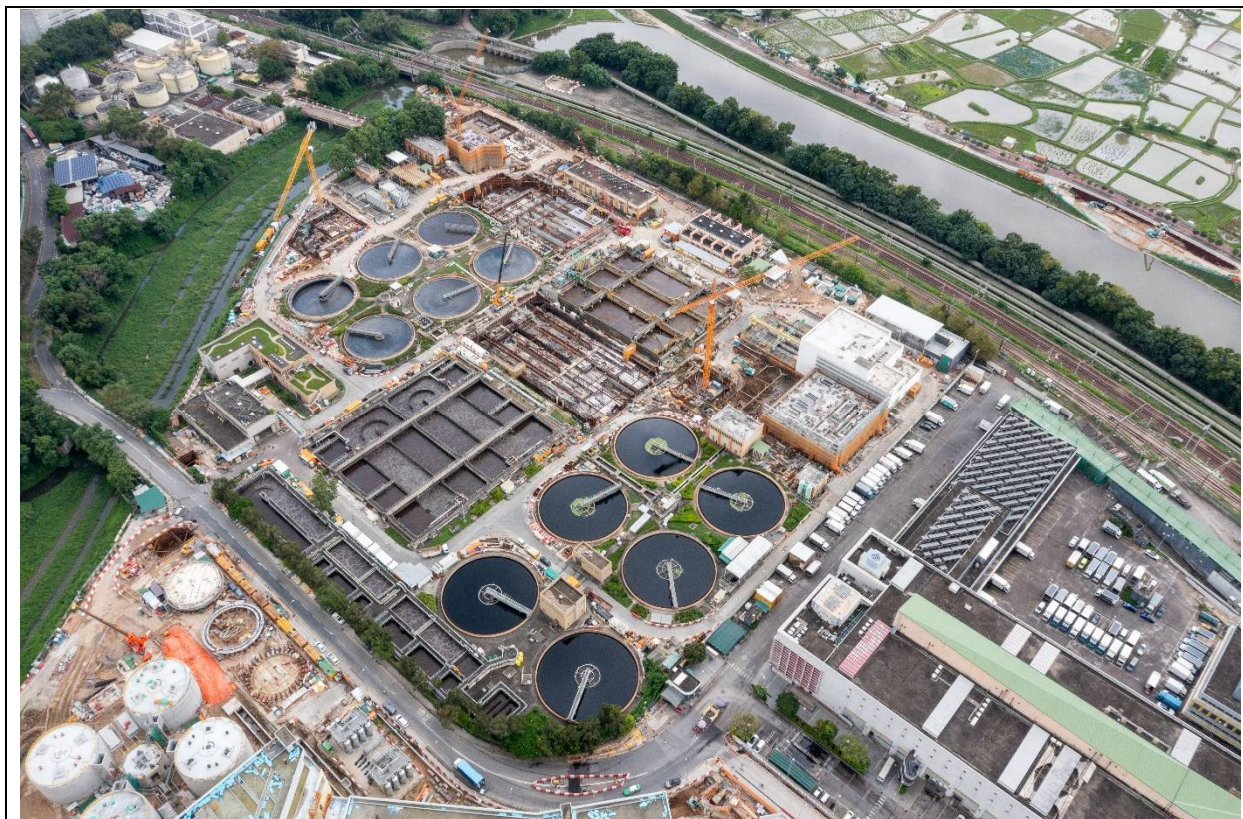
描述： 工地甲部分及乙部分的1號航拍照片 (拍攝於2023年7月21日)
