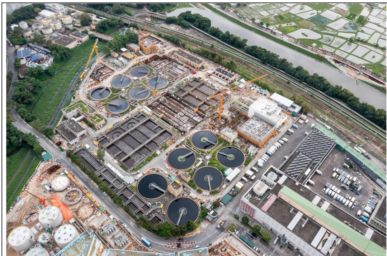
描述： 工地甲部分及乙部分的1号航拍照片 (拍摄于2023年7月21日)
