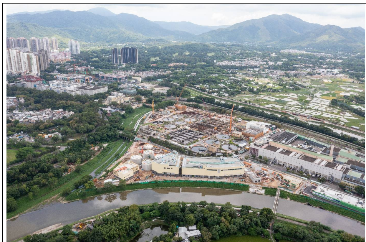
描述： 工地丙部分的1号航拍照片 (拍摄于2023年7月21日)
