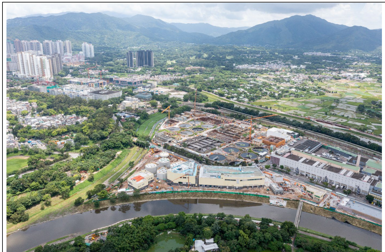
描述： 工地丙部分的1號航拍照片 (拍攝於2023年6月20日)
