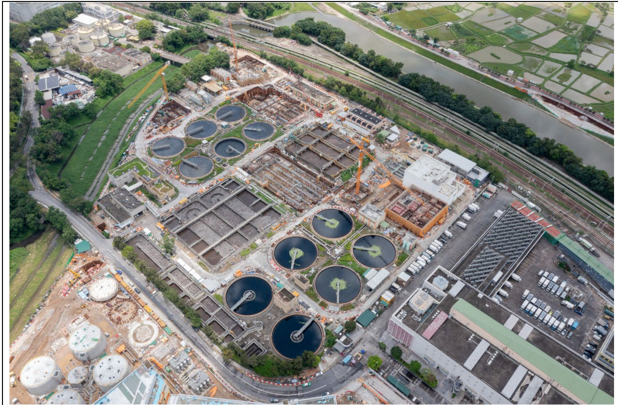
描述： 工地甲部分及乙部分的1号航拍照片 (拍摄于2023年6月20日)
