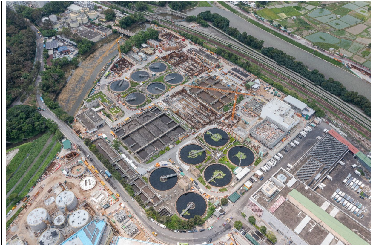
描述： 工地甲部分及乙部分的1號航拍照片 (拍攝於2023年5月23日)
