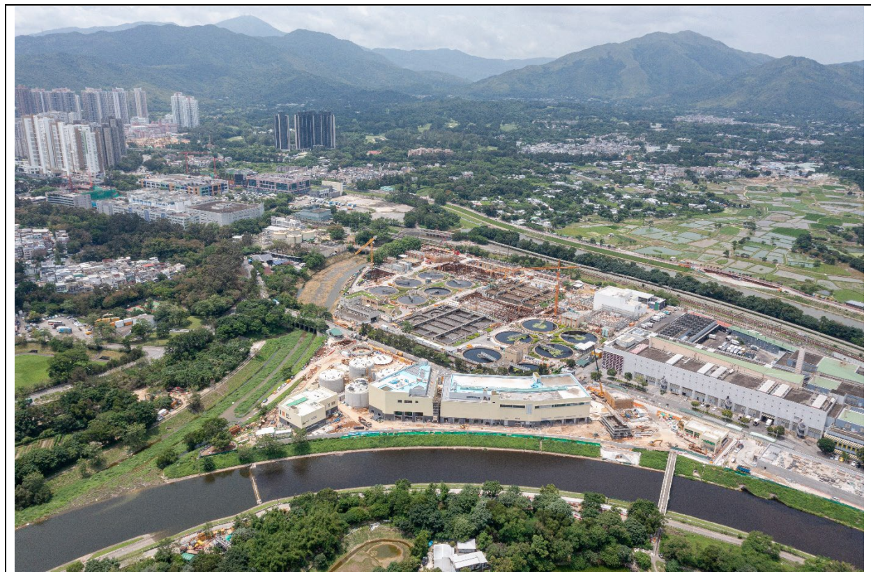
描述： 工地丙部分的1號航拍照片 (拍攝於2023年5月22日)
