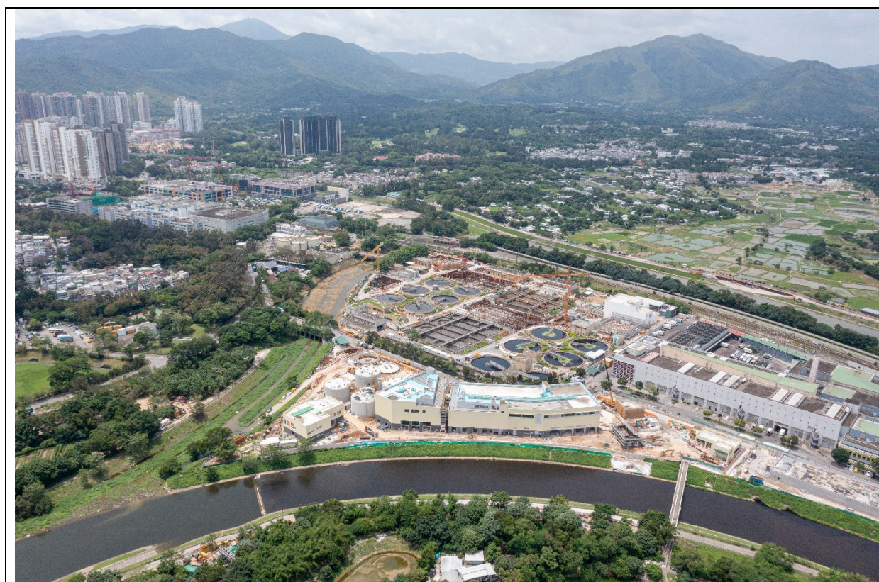
描述： 工地丙部分的1号航拍照片 (拍摄于2023年5月22日)
