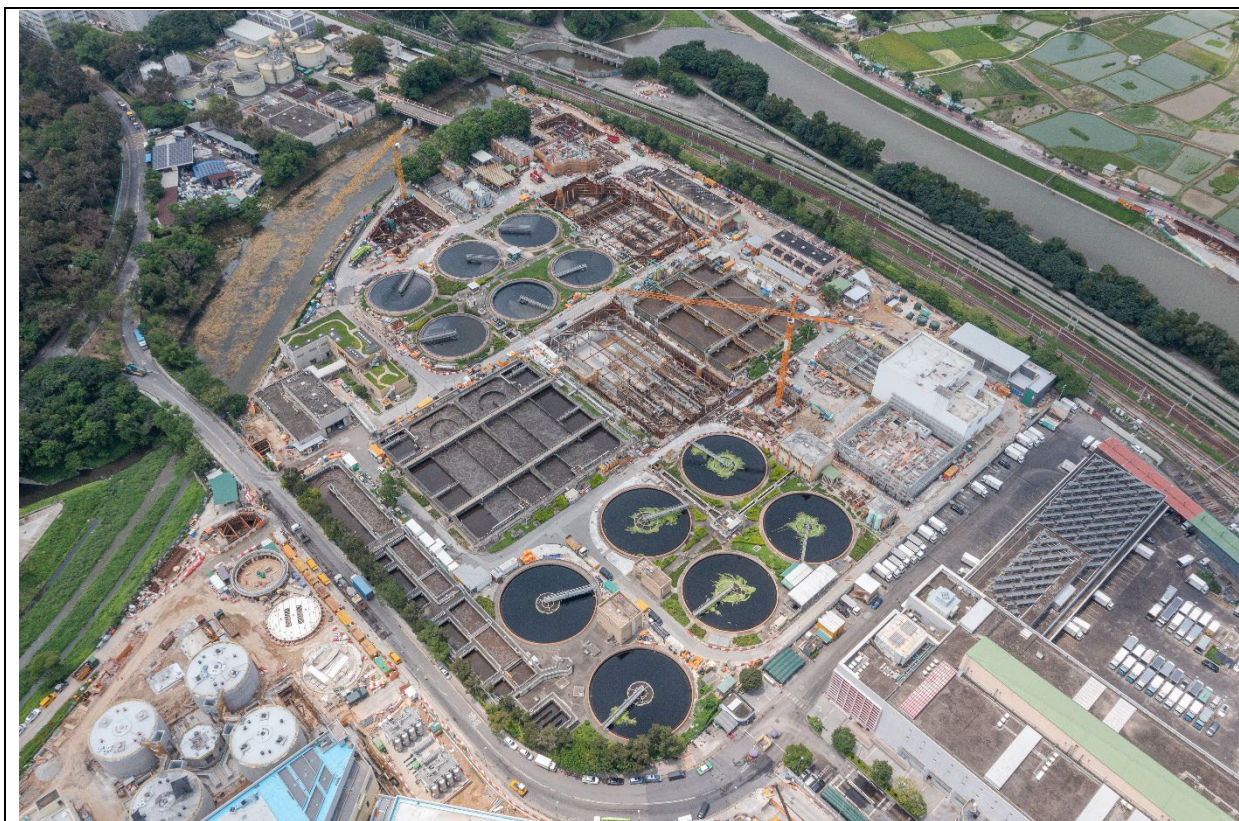
描述： 工地甲部分及乙部分的1号航拍照片 (拍摄于2023年5月23日)
