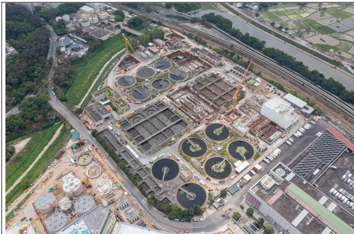
描述： 工地甲部分及乙部分的1号航拍照片 (拍摄于2023年4月17日)
