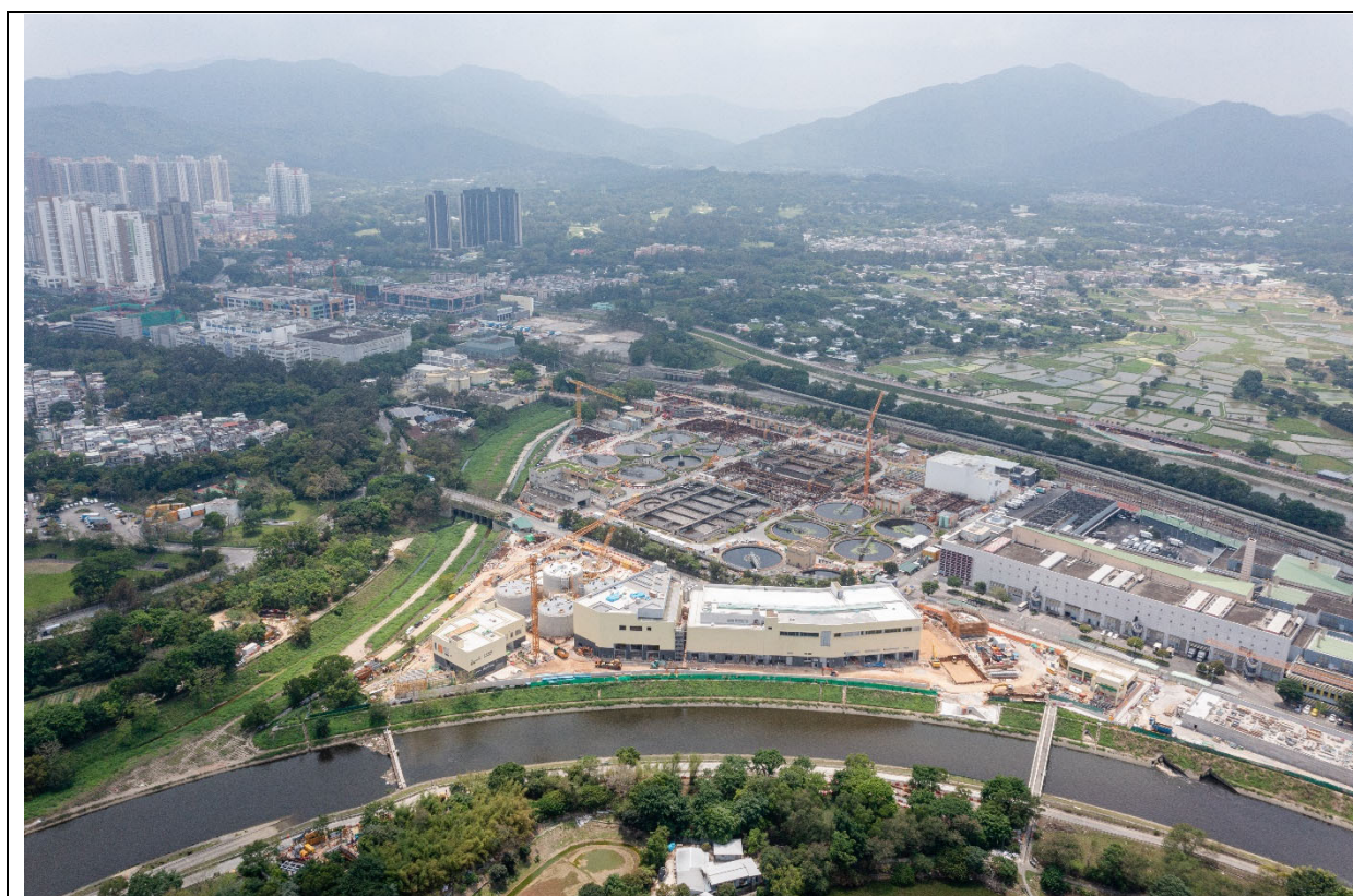
描述： 工地丙部分的1号航拍照片 (拍摄于2023年4月17日)
