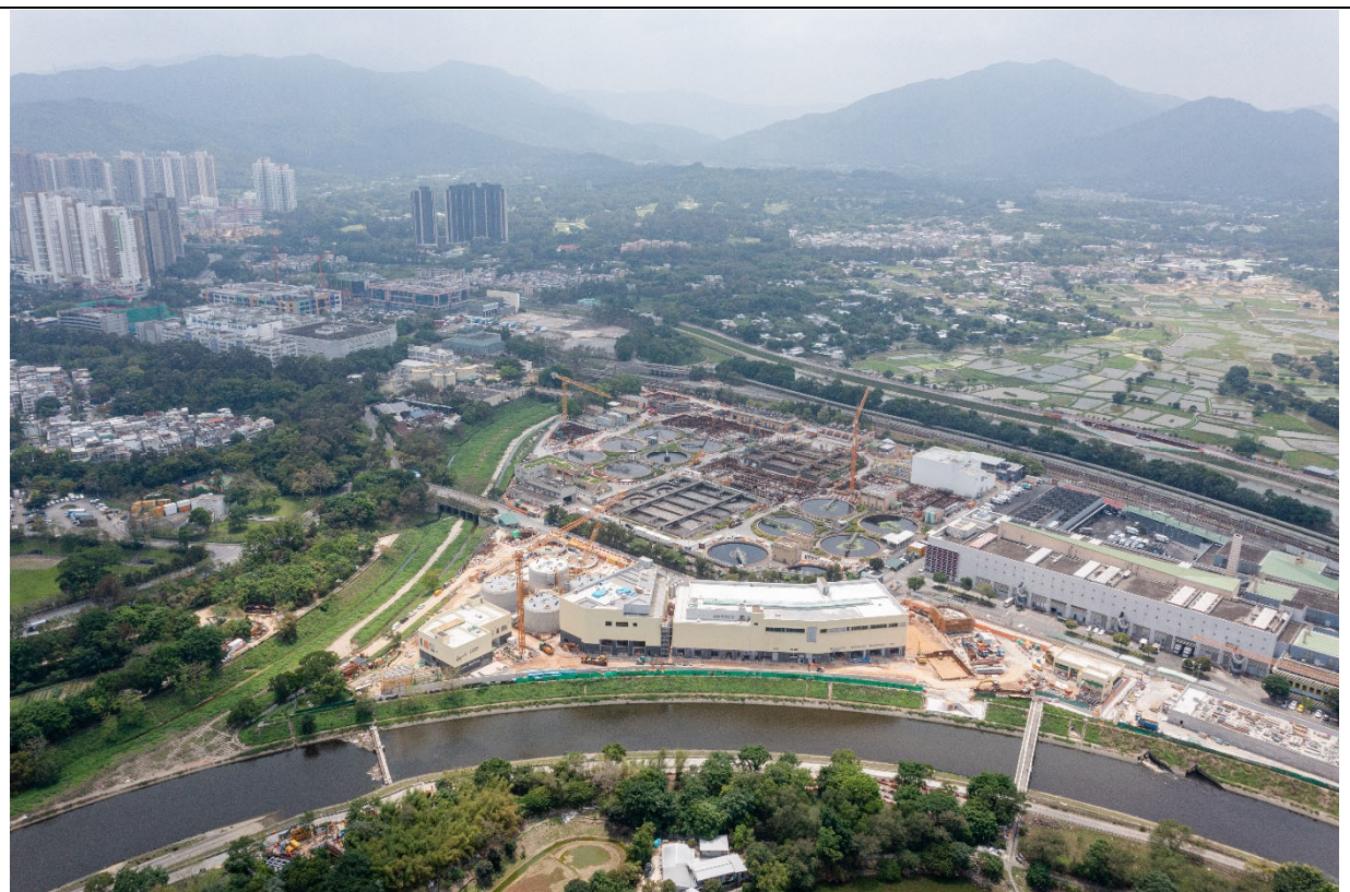
描述： 工地丙部分的1號航拍照片 (拍攝於2023年4月17日)
