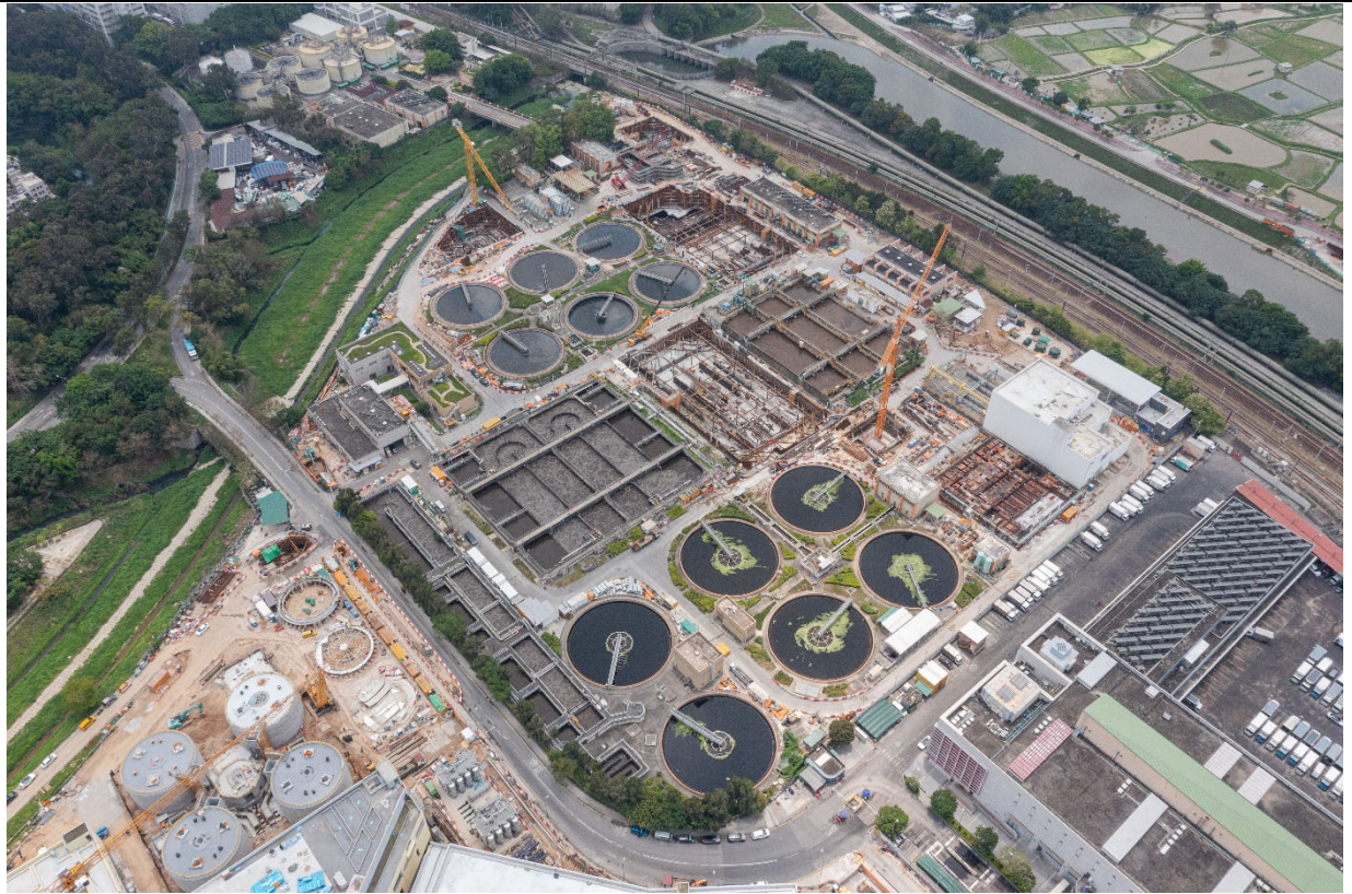
描述： 工地甲部分及乙部分的1號航拍照片 (拍攝於2023年4月17日)
