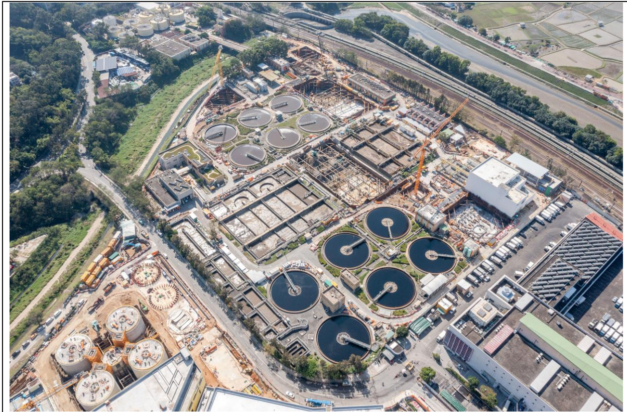
描述： 工地甲部分及乙部分的1號航拍照片 (拍攝於2023年1月18日)
