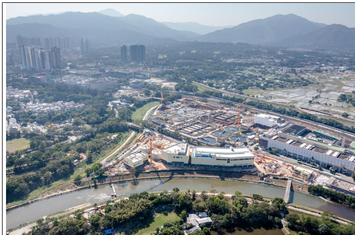
描述： 工地丙部分的1号航拍照片 (拍摄于2023年1月18日)
