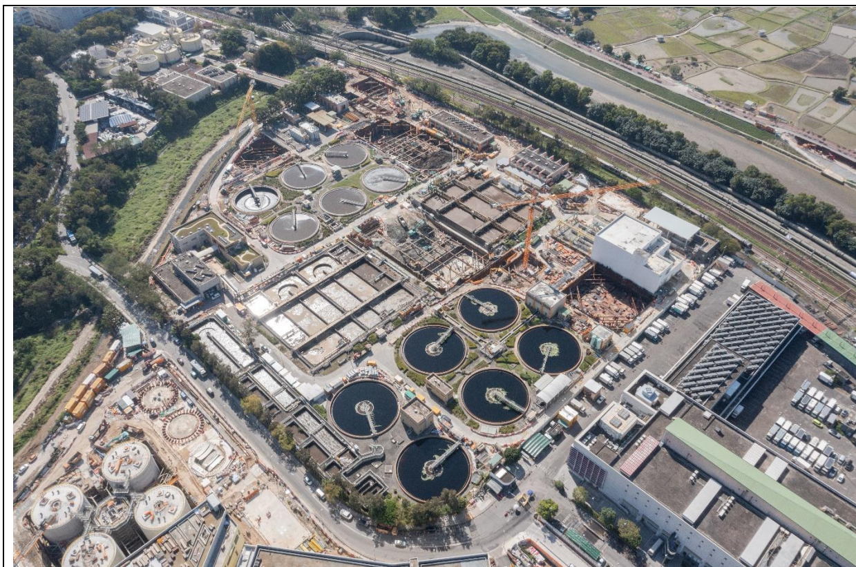
描述： 工地甲部分及乙部分的1号航拍照片 (拍摄于2022年12月19日)
