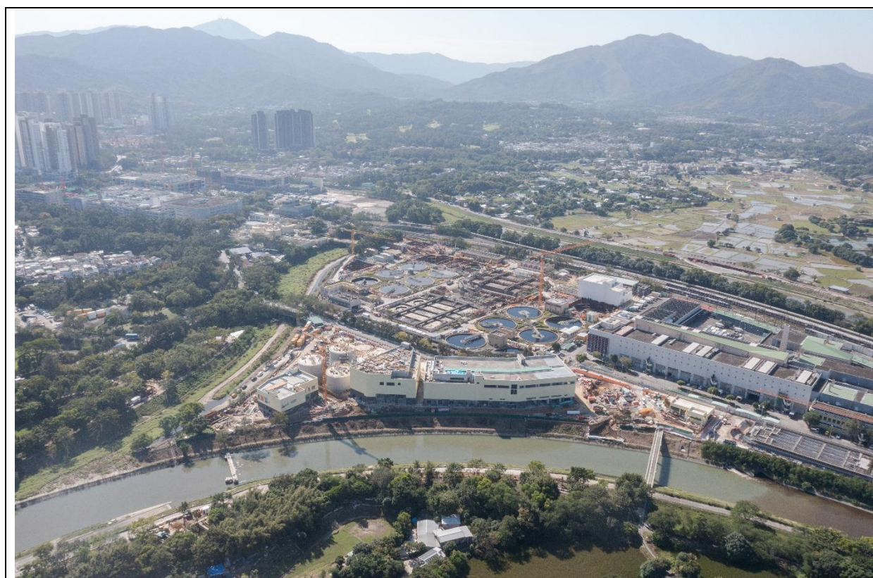
描述： 工地丙部分的1号航拍照片 (拍摄于2022年12月19日)
