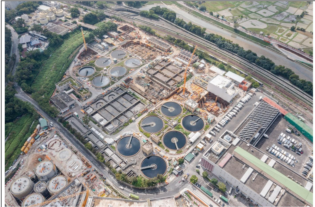
描述： 工地甲部分及乙部分的1號航拍照片 (拍攝於2022年11月18日)
