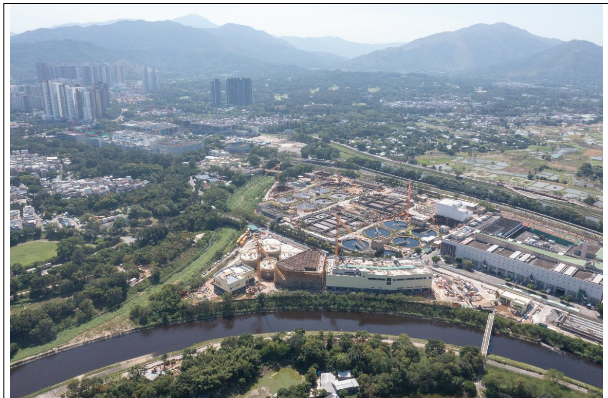
描述： 工地丙部分的1號航拍照片 (拍攝於2022年10月21日)
