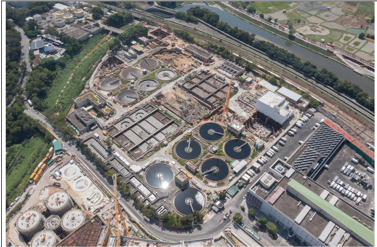
描述： 工地甲部分及乙部分的1號航拍照片 (拍攝於2022年10月21日)
