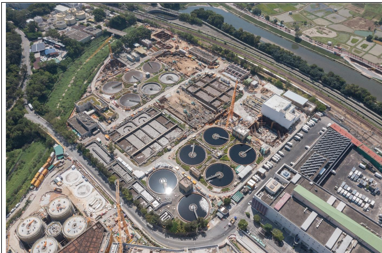
描述： 工地甲部分及乙部分的1号航拍照片 (拍摄于2022年10月21日)
