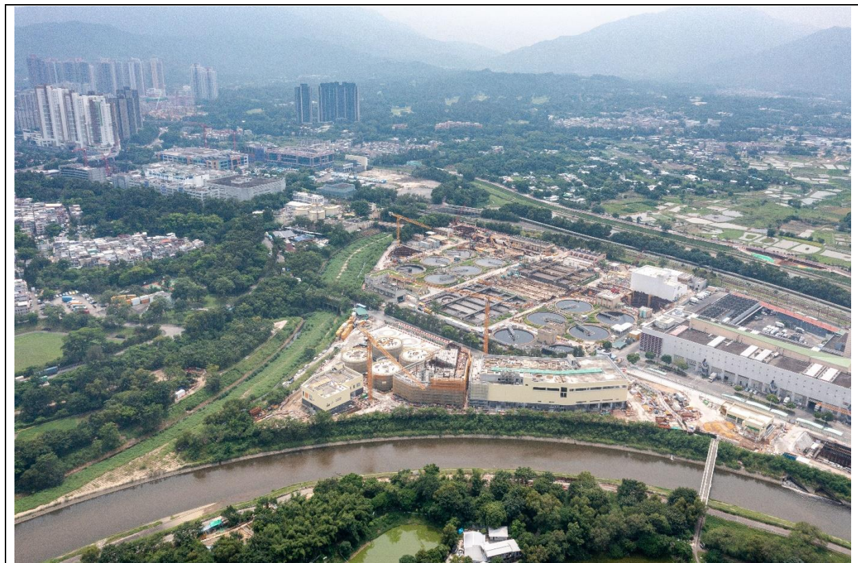
描述： 工地丙部分的1號航拍照片 (拍攝於2022年9月21日)
