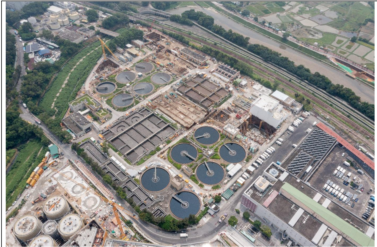
描述： 工地甲部分及乙部分的1號航拍照片 (拍攝於2022年9月19日)
