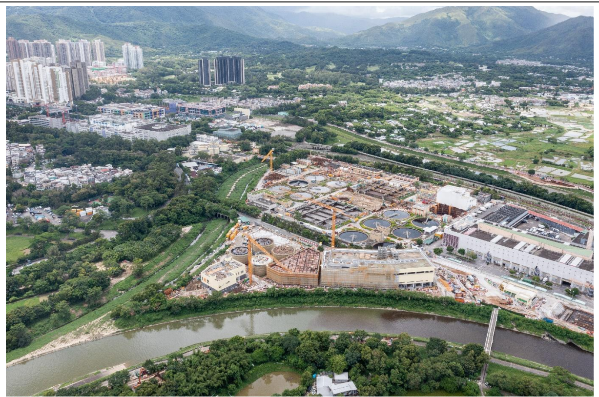
描述： 工地丙部分的1號航拍照片 (拍攝於2022年8月19日)
