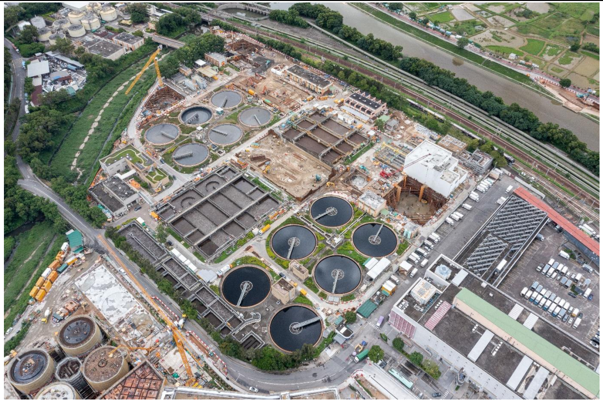
描述： 工地甲部分及乙部分的1號航拍照片 (拍攝於2022年8月19日)
