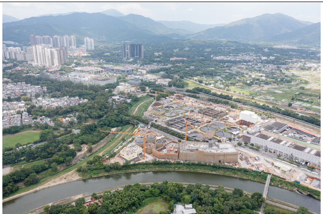
描述： 工地丙部分的1号航拍照片 (拍摄于2022年7月26日)
