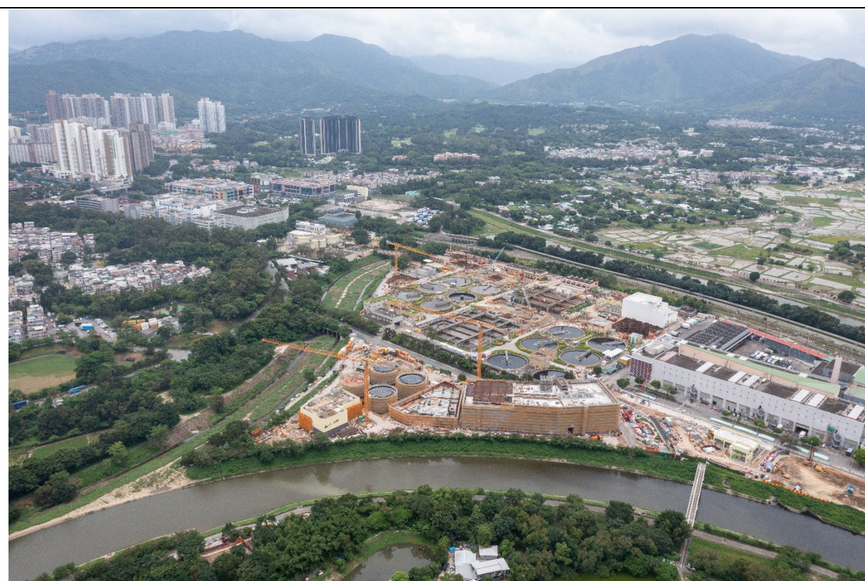
描述： 工地丙部分的1號航拍照片 (拍攝於2022年6月20日)
