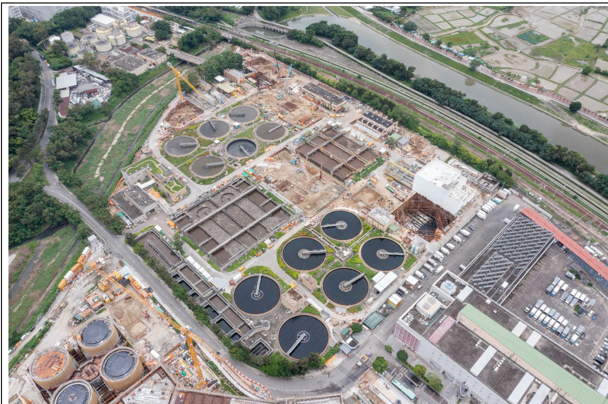
描述： 工地甲部分及乙部分的1號航拍照片 (拍攝於2022年6月20日)
